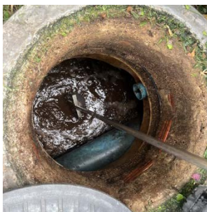
จุดที่ 1 คุณภาพน้ำเสียก่อนการเข้าสู่ระบบบำบัดน้ำเสียบริเวณถังส่วนแยกกาก (Solid separation chamber)
